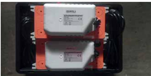
Öertli Kondensat Doppelhebeanlage
