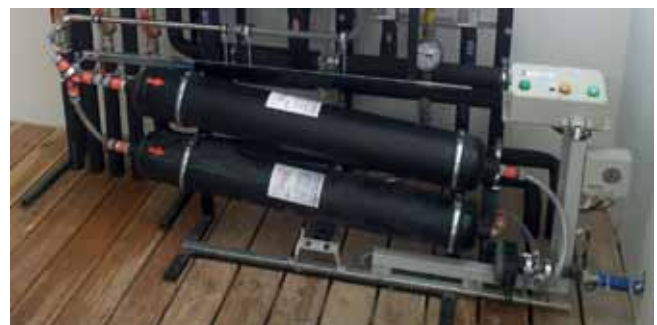
Öertli Neutralisation mit Heizband und Regeleinheiten
